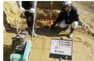
転圧状況確認
