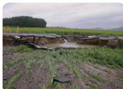
圧送管破損事故による被害状況
