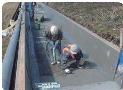
開水路の長寿命化対策工事
