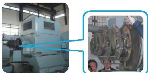
揚水機（高圧電動機）の焼損による緊急停止事故
