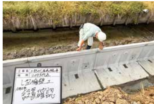
L字型擁壁工設置確認状況
