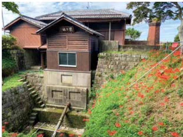
龍ヶ池揚水機場(豊郷町)
