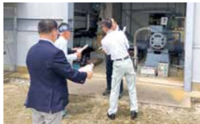
葉山ポンプ場現地視察
